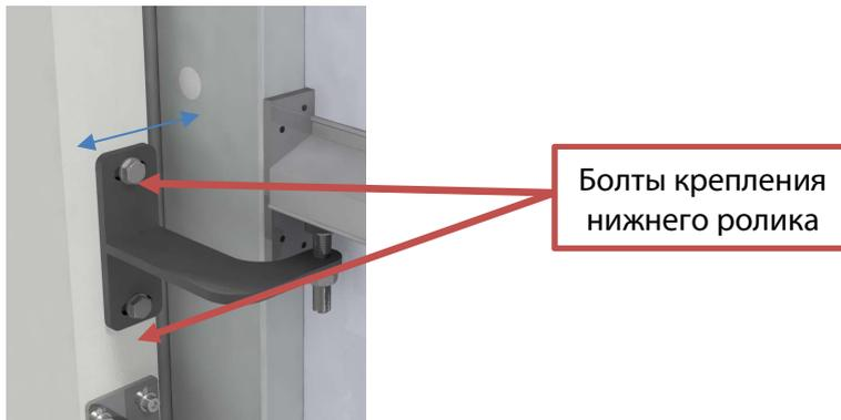
• Регулировка прижима нижнего уплотнителя выполняется отдельно с двух сторон полотна в следующей последовательности:
